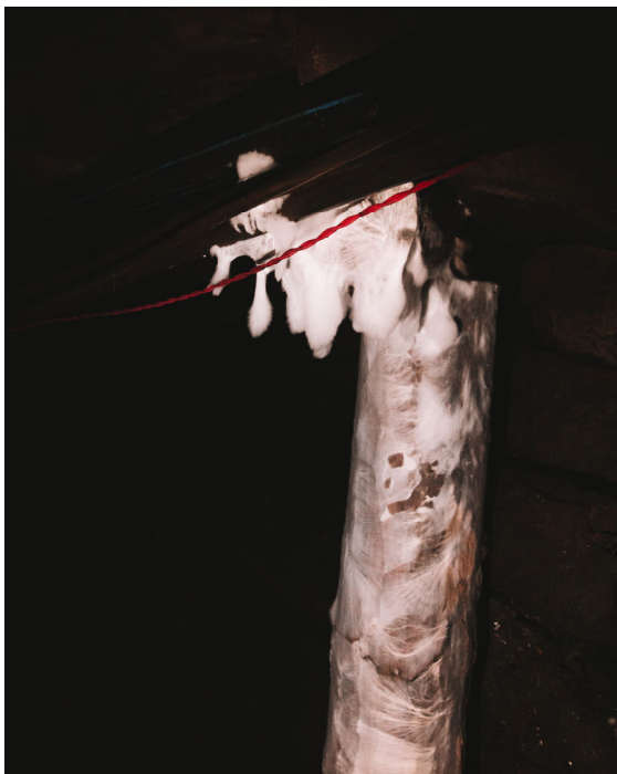
Vom Pilz befallener Grubenstempel. (Foto: ts)
