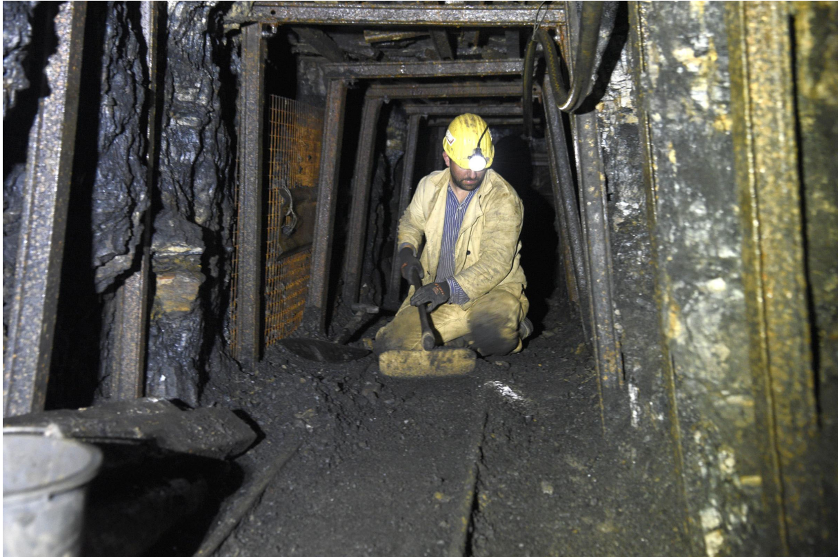
Arbeiten in der Verbindungsstrecke zwischen Abbau und Neuer Rösche. (Foto: eb)
