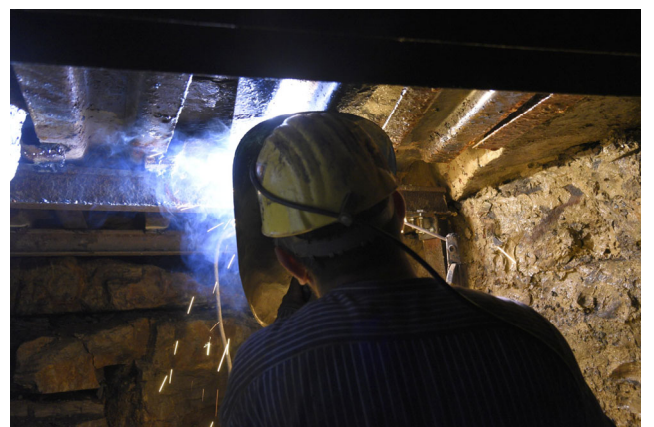
Schweißarbeiten in der 1. Ostdiagonale. (Foto: eb)
