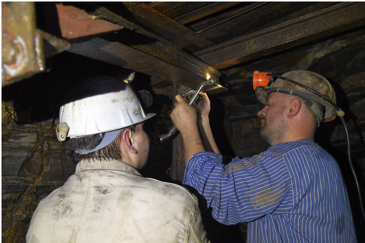
Die Montage einer Kappe im 1. Bremsberg, hier mit Marcus und Lars. Ein seltenes Foto, da bei dieser Arbeit jede Hand gebraucht wird, auch die vom Fotografen. (Foto: eb)
