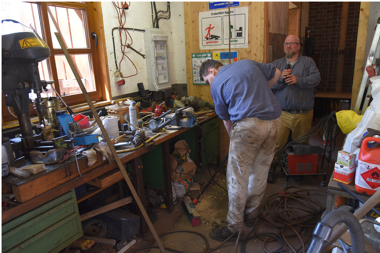
Unsere Werkstatt. Im Hintergrund ist die erneuerte Stromverteilung zu erkennen. Hier mit Lars und Klaus. (Foto: eb)
